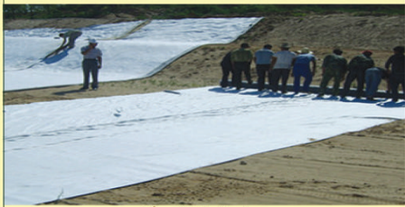
Lắp đặt thủ công
